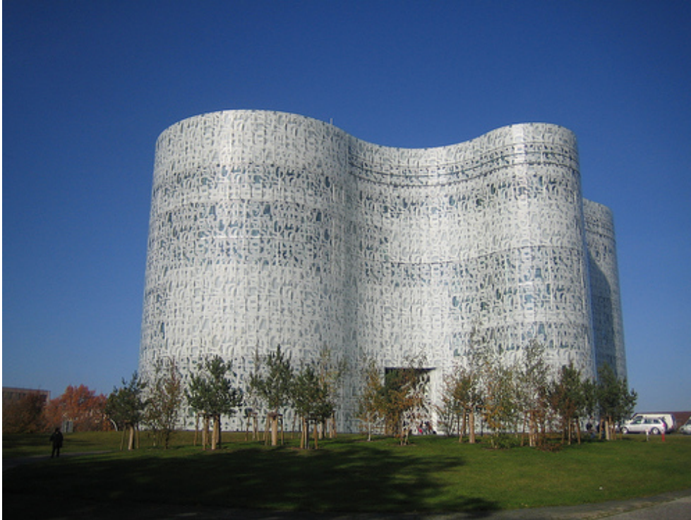
Abb. 4 IKMZ Cottbus, Außenansicht
