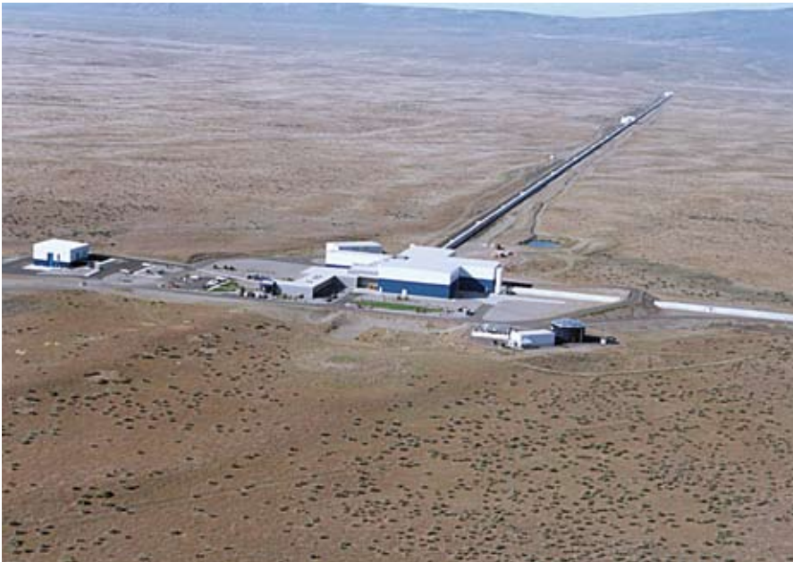
Dieses Luftbild zeigt den interferometrischen Detektor LIGO mit seinen beiden vier Kilometer langen Messstrecken in Hanford, südlich von Seattle (USA).
