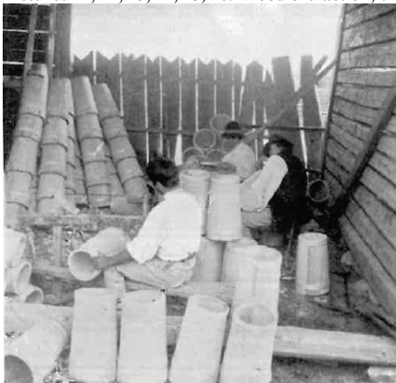
Fig. 39 — L'atelier de tonnellerie.
