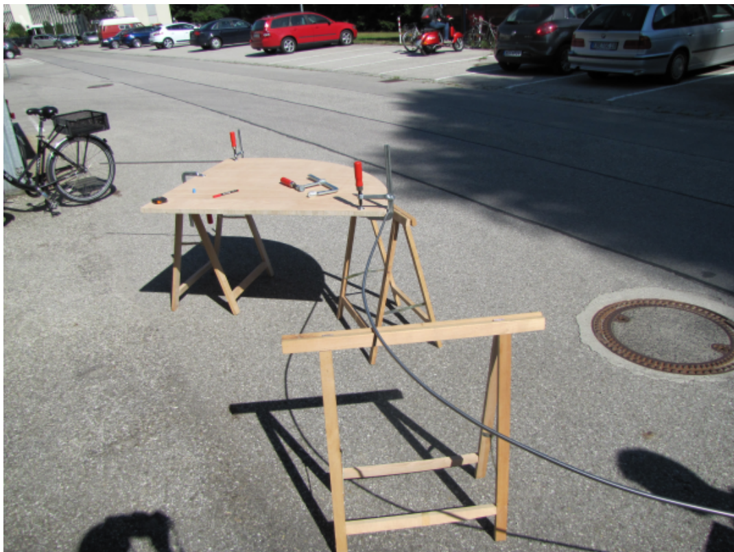
Abbildung 3.8: Fertigung des kritischen Führungsrohres
