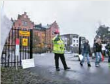
Von schwedischen Gewerkschaften blockierte Baustelle in Vaxholm
