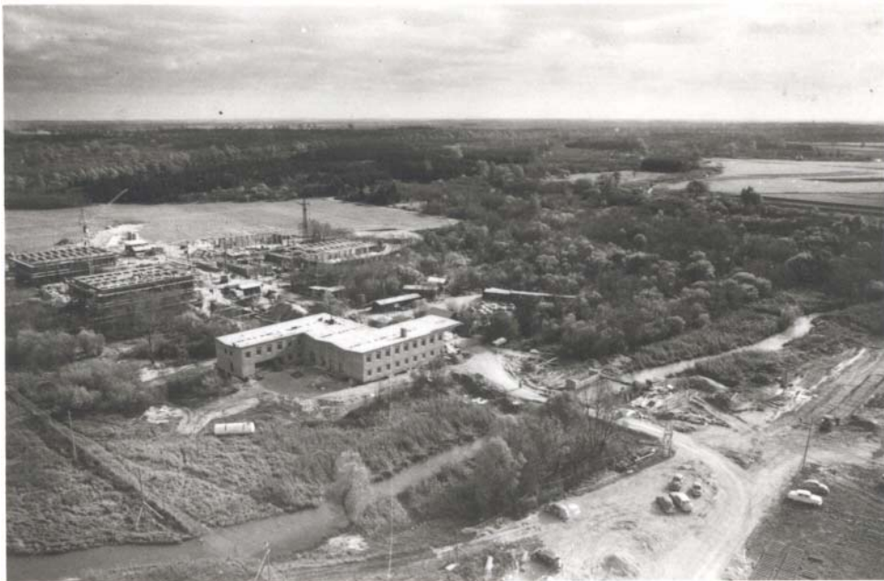
Abb. 10: Beginn des 1. Bauabschnitts der Forschungsbauten der Institut für Plasmaphysik GmbH im Jahr 1960
