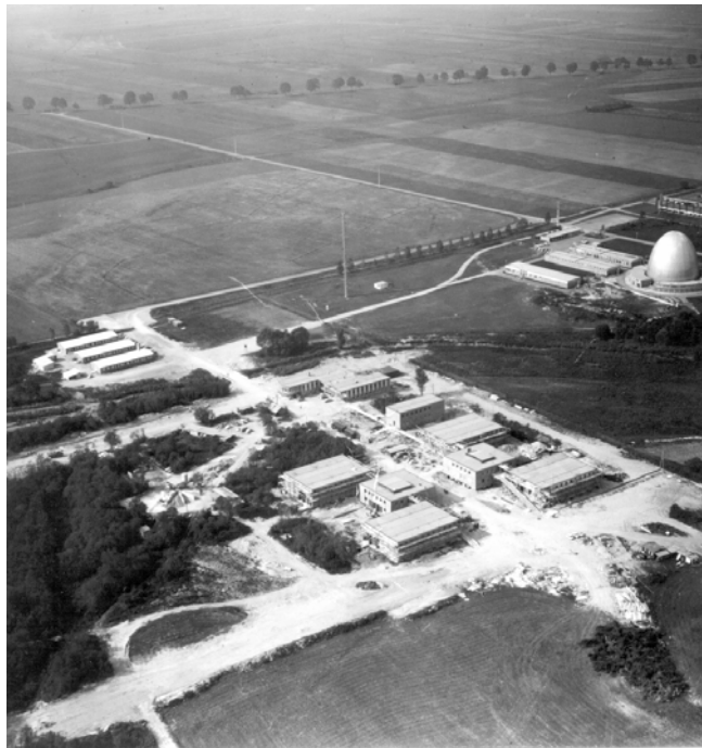
Abb. 12: Gebäude des 1. und 2. Bauabschnitts (26.03.63)
