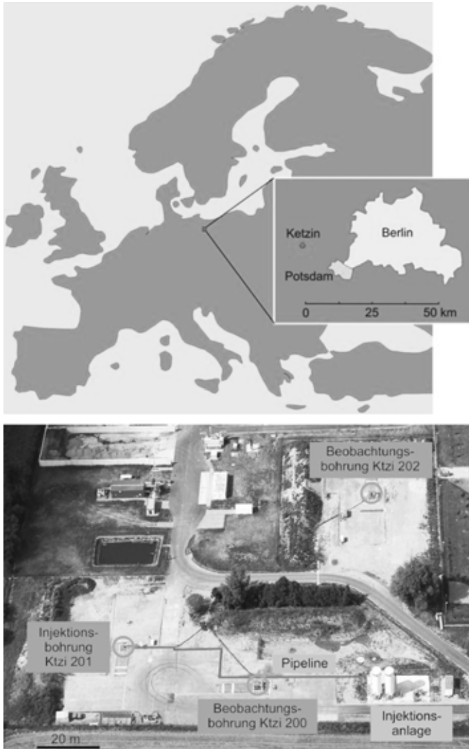
Abbildung 5.5: Pilotstandort zur geologischen CO 2 -Speicherung im Haveländischen Ketzin bei Berlin und Potsdam (oben). Luftbild des Standortes mit Injektionsanlage und Bohrungen.
