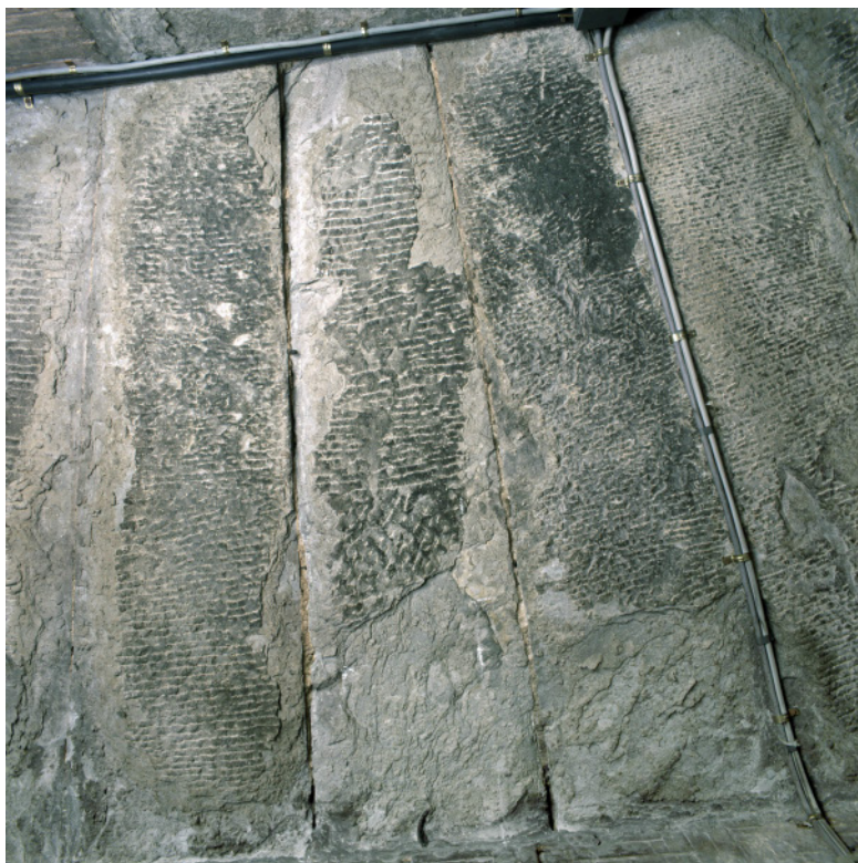
Abb. 6.8: Kuppel von Santa Maria del Fiore, Schlussring, Decke der Kappe 4 (Süd-Osten) mit den fächerförmig angeordneten großen Macignosteinen (Foto: ECHO, Rullo 11 Foto 05).
