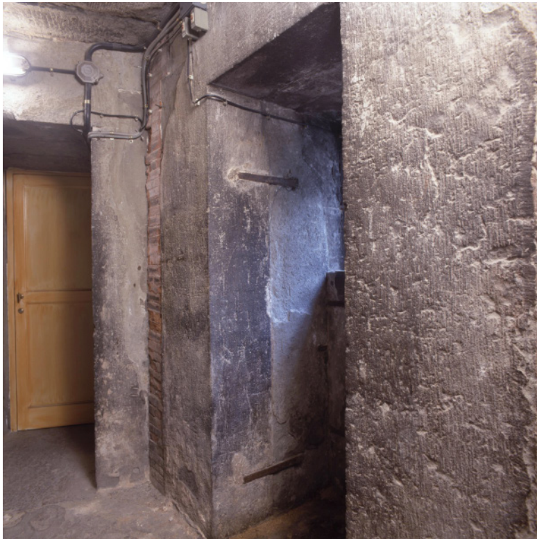
Abb. 6.6: Kuppel von Santa Maria del Fiore, Innenansicht des Schlussringes, Kappe 4 (Süd-Osten) Richtung Öffnung zum Laternenraum (Foto: ECHO, Rullo 10 Foto 02).
