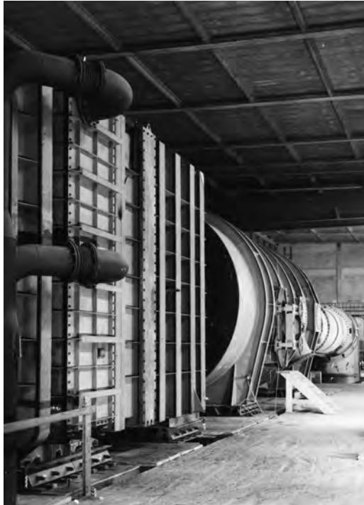
Abb. 7.1: Transsonischer Windkanal in der AVA, 1963.
