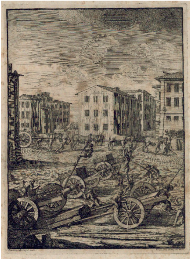
Abb. 2.43: Nicola Zabaglia, Aufladen von Travertinblöcken auf eine bastarda . Im Hintergrund eine von vier hintereinander gespannten Pferden gezogene, mit einem Travertinblock beladene bastarda , aus Zabaglia 1743, f. 20r, Taf. XV (Bibliotheca Hertziana).
