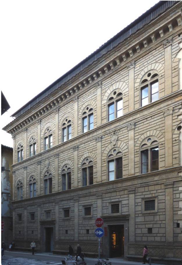
Abb. 2.65: Leon Battista Alberti, Palazzo Rucellai, Florenz, 1446–1451, man beachte das opus reticulatum im Sockel (Foto: H. Schlimme).
