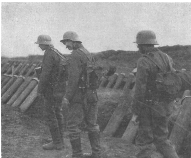
Leitungslagen am Gaswerfer, ca. 1915. (Quelle: Henrici 1931, 564)
