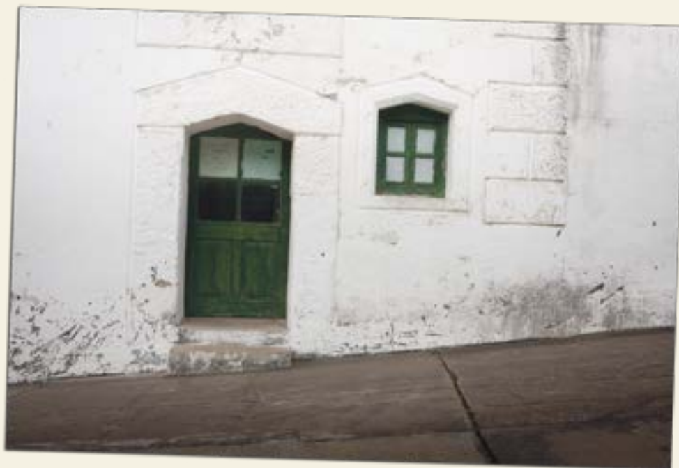
Detalle de edificio original de la LEMCO de 1865.
