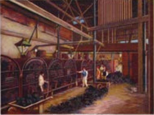
CHAMBRE des CHAUDIÈRES
