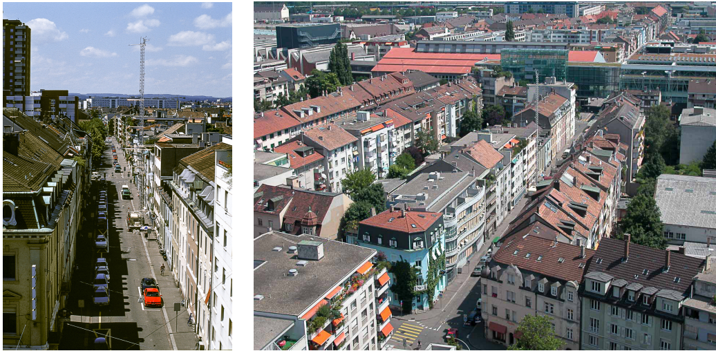
a) Tower in Basel-Sperrstraße (BSPR)
