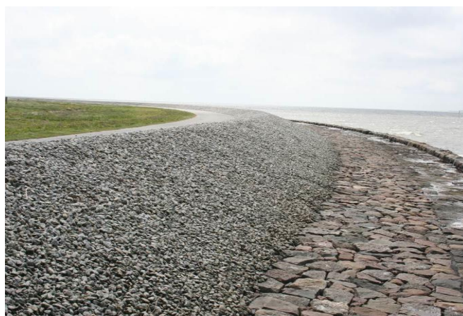
Abb. 3b: Moderner wasserdurchlässiger Rauhstreifen (Halligigel) auf Langeneß. Schotter wird mittels eines Zwei-Komponenten-Klebers (Elastocoast®, BASF) zu einem Rauhstreifen modelliert. Dem Streifen vorgelagert ist ein wasserundurchlässiges Pflaster aus Basaltblöcken. Foto: Deicke 2014.
