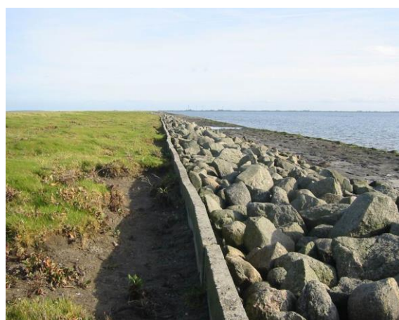
Abb. 3c: Alter Rauhstreifen auf Nordstrandischmoor. Das Niveau der binnenseitigen Salzmarsch wächst über die Höhe des Rauhstreifens hinaus. Foto: Schindler 2012
