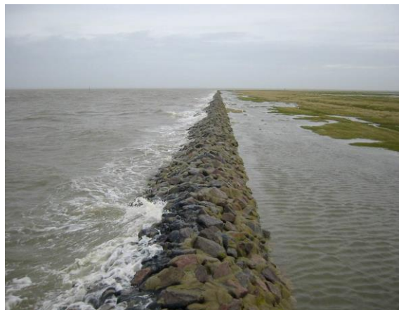
Abb. 3a: Konservativer wasserdurchlässiger Rauhstreifen (Halligigel) auf Nordstrandischmoor. Foto: Schindler 2011.
