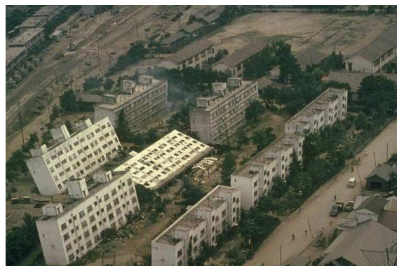
Abbildung 1: Erdverflüssigung in Niigata 1964
