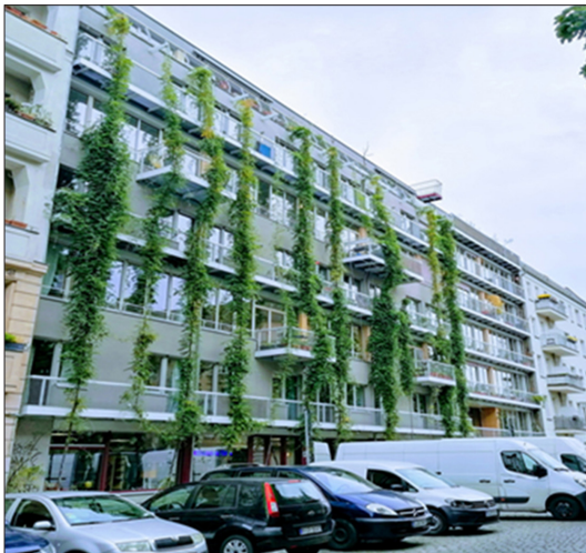
Abb. 15: Fassadenbegrünung (Foto: B. Gabriel).
