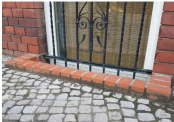
Abbildung 1: Lichtschacht mit kostengünstigem (oberirdischen) Hochwasserschutz (Backsteinreihe); Quelle: GDV
