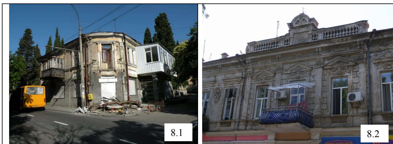
Рис. 8. Разрушение фасадов старинных зданий
