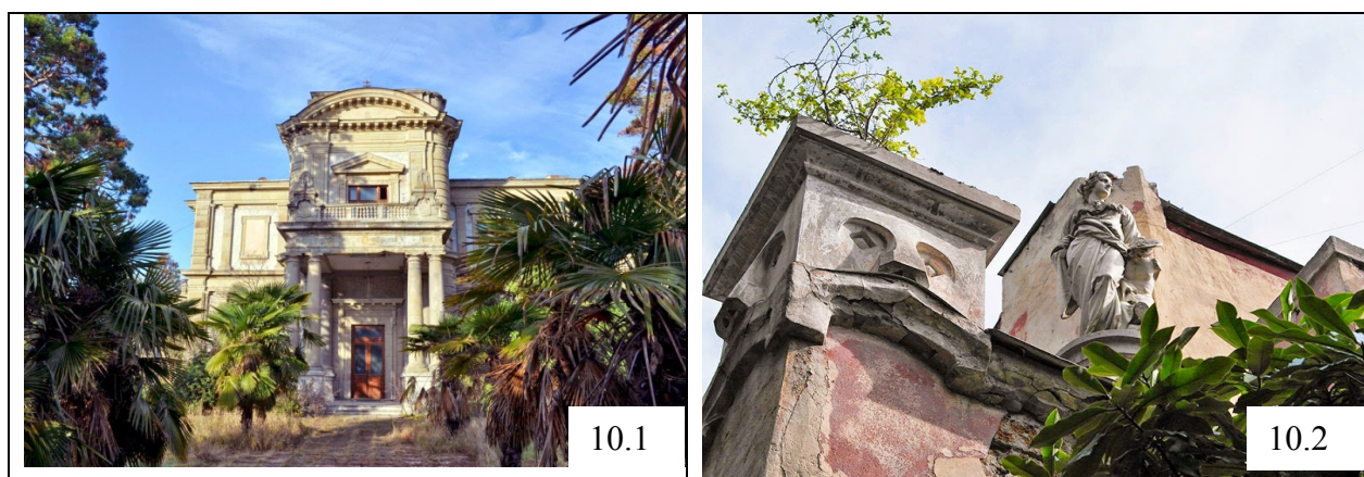
Рис. 10. Зброшенныя памятники архитектуры в историческом центре Ялты
