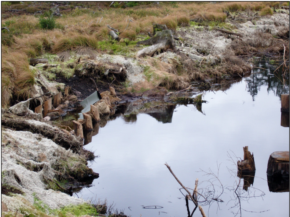
Abb. 22: Dammbbruch am Kolk OW3.
