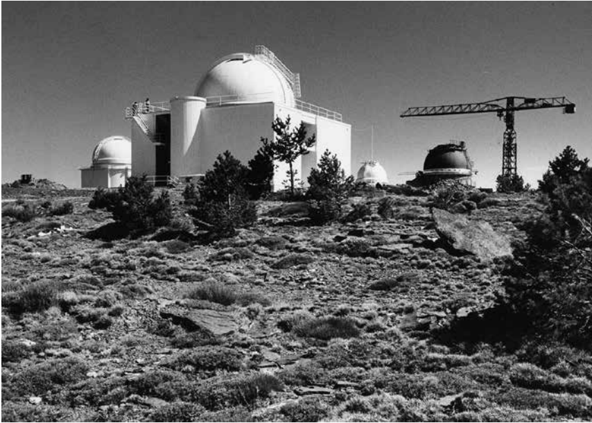
Abb. 19: Das Observatorium auf dem Calar Alto (Provinz Almería, Spanien) in der Bau-phase, ca. 1978/79.
