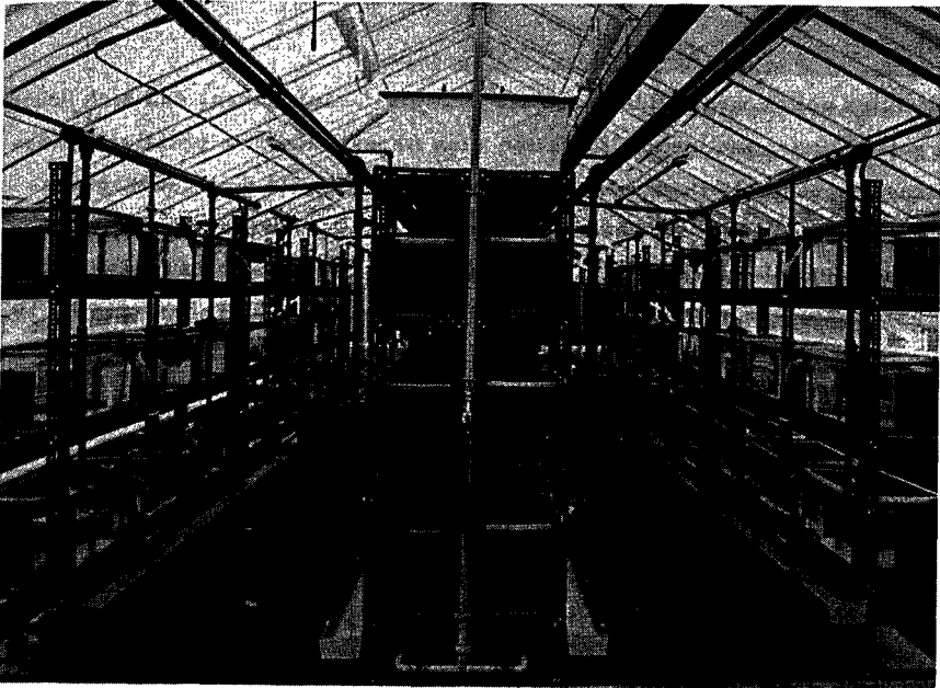
Abb. 12. Neue Aquarienanlage mit insgesamt 108 Glasaquarien. Oben Aufheizwannen, dunkle Rohre zur Wasserführung (Zu- und Ableitung), helle offene Rinnen als Schmutzwassersammelrinnen zu den unterirdischen Klärbecken.
