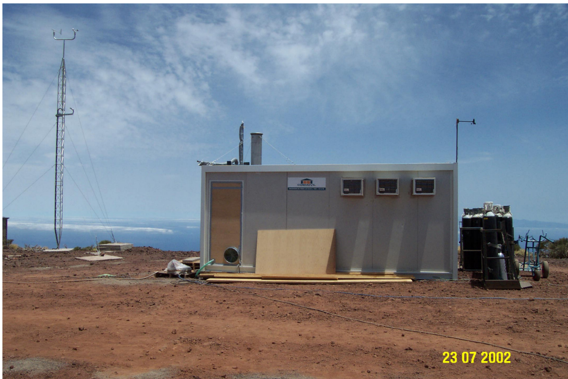
Abbildung 6.2: Seitenansicht des Messcontainers. Links oben auf dem Dach wird Atmosphärenluft in den Gebläseeinlass eingesaugt und durch den runden Auslass in der Holztür links unten wieder nach außen abgeführt. Ebenfalls zu sehen sind rechts oben drei Klimaanlage, mit deren Hilfe die Containertemperatur möglichst konstant gehalten wurde. Rechts auf dem Containerdach ist unsere eigene Wetterstation für die lokale Messung der Windrichtung und Windgeschwindigkeit zu sehen, während die Messung dieser Parameter durch die Station auf dem links zu sehenden Mast in größerer Höhe erfolgte.
