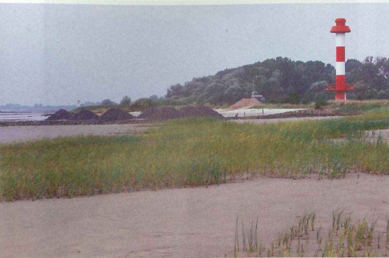
Aufgrund der erheblichen Landverluste nach der letzten Elbvertiefung werden jetzt die Inselufer von Pagensand mit Steinpackungen gesichert. Die Uferlinie verlief ursprünglich etwa vom linken Schlackehaufen auf den Betrachter zu. Auch die Standsicherheit des Unterfeuers bereitet Sorgen. Rechts: Die Abbruchkante des Nordspülfeldes ist in den letzten fünf Jahren um bis zu 6 m abgetragen worden.
