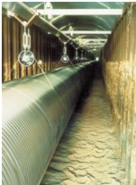
Abb. 6. Aufhängung des Vakuumschirms bei GEO 600.
