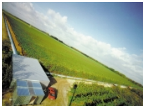
Abb. 8. Das südlich von Hannover gelegene GEO 600. Man sieht die beiden 600 m langen Gräben, in denen das Vakuumrohr aufgehängt ist. Im Zentralhaus (vorn) befinden sich Laser, Strahlteiler und Signalaufnahme, in den beiden kleineren Gebäuden (links und rechts) die Endspiegel des Interferometers.
